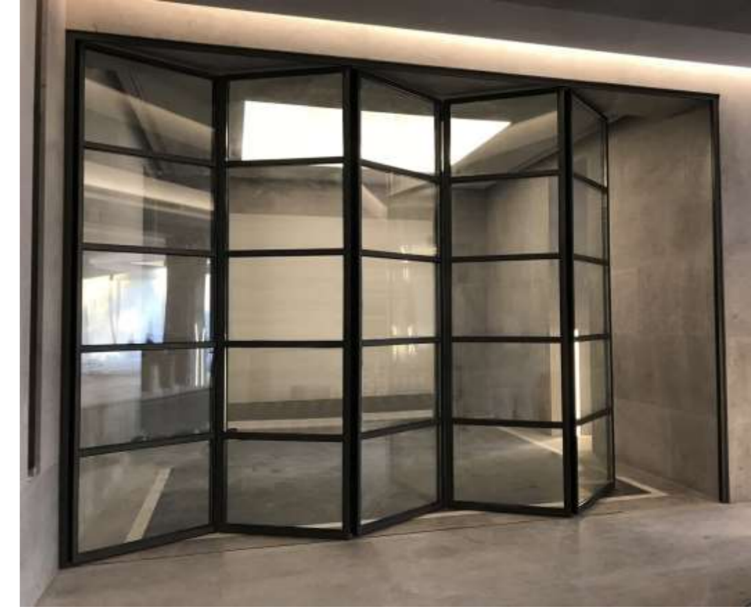
HAP Köşkü, Kuzguncuk İstanbul. İnce seri çelik kapı pencere profil sistemi ile Kayar katlanır kapılar, tek kanat ve çift kanat yüksek kapılar
