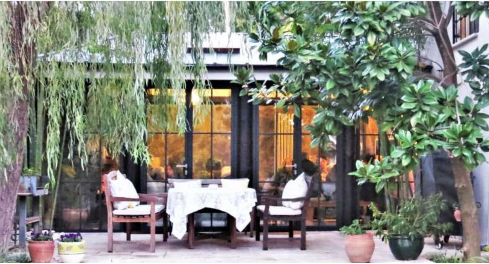
Banu Yüce Villası, Zekeriyaköy, İstanbul. İnce seri çelik kapı ve pencere doğramaları yapıldı.
