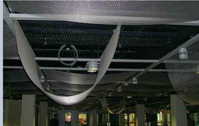
Bir slot profiline sokulmuş örgü
