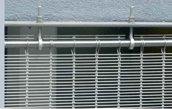
Üst Sabitleme: Halkalı civata ve yuvarlak çubuk
