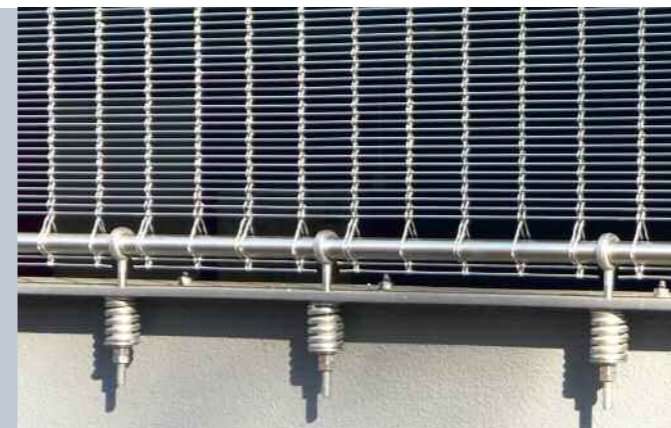
Alt Sabitleme: Halkalı civata, basınç yayı ve yuvarlak çubuk
