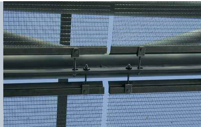
Düz gerilim profilli ve çatal vidalı örgü
