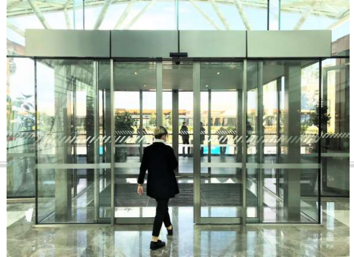
İstinyepark Alışveriş Merkezi, İzmir Tüm girişlerde Paslanmaz çelik Kayar Kapılar
