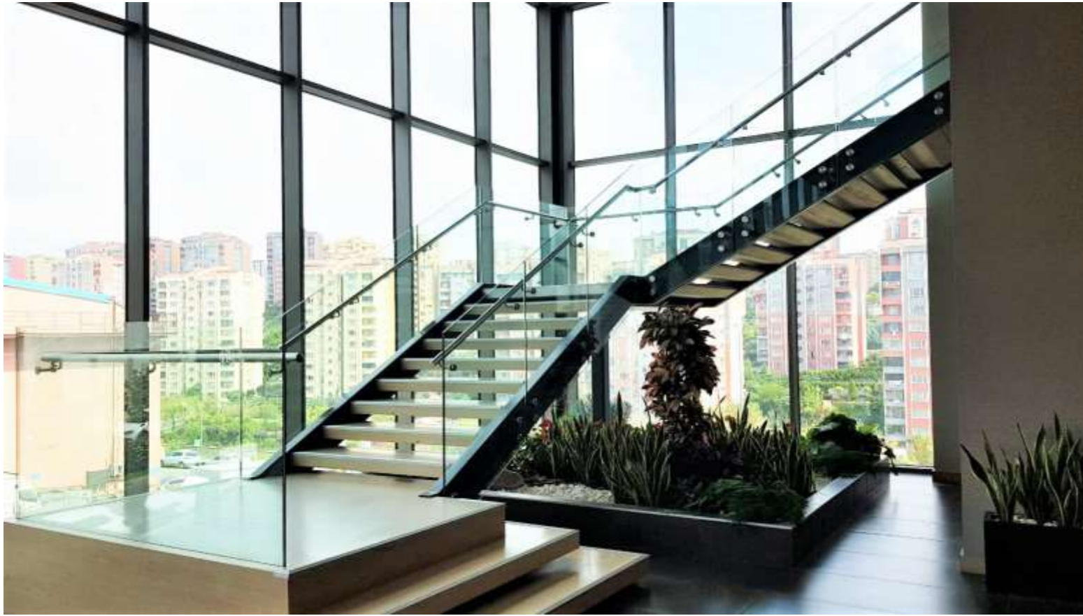
Özak Tekstil İstanbul. Özel tasarım çelik merdiven, cam ve paslanmaz çelik aksesuarlı merdiven korkulukları.
