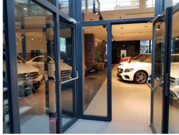
EI90 Camlı yangın bölmeleri ve camlı yangın kapıları Mengerler Mercedes Showroom Etiler İstanbul
