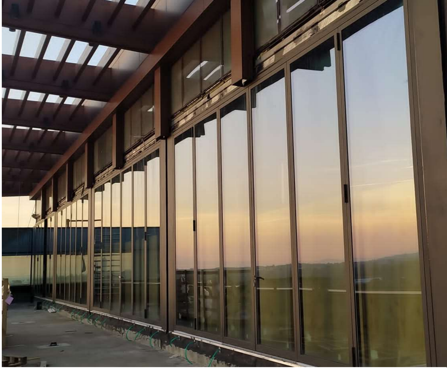
İstinyepark Kompleksi Hyatt Regency Otel Teras Cephesi kayar katlanır cephesi, inşaat sırasında, İzmir
