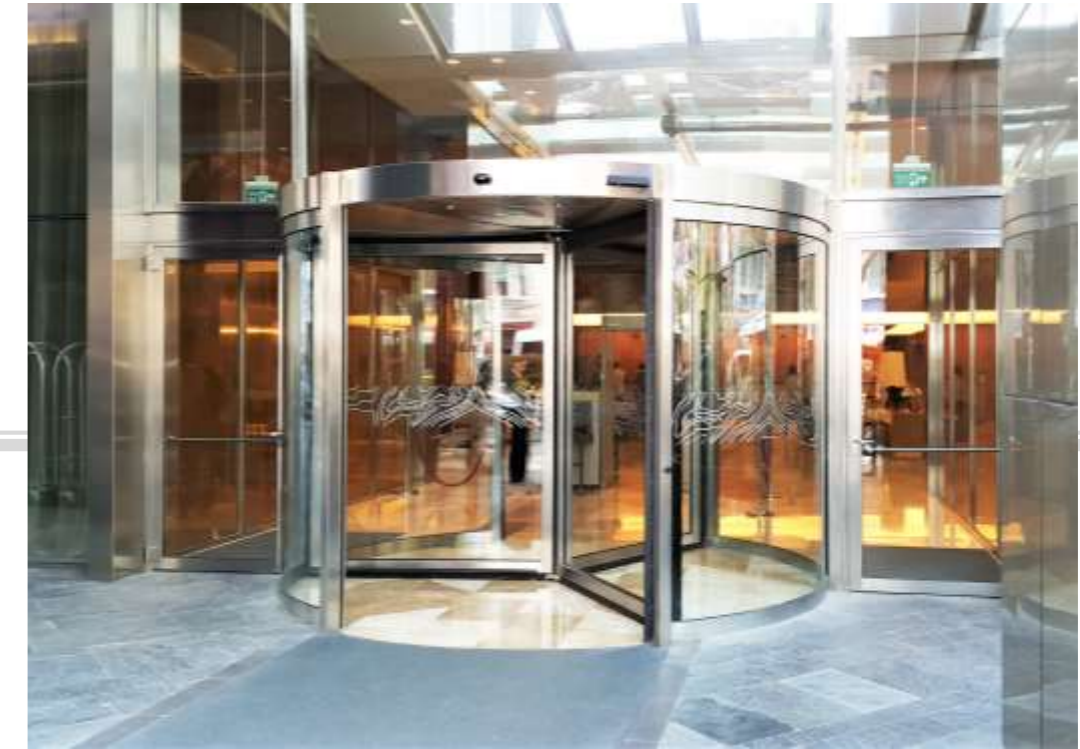
Şişli Marriot Otel paslanmaz çelik Ana Giriş Cephesi, paslanmaz çelik döner kapı ve acil çıkış kapıları, İstanbul
