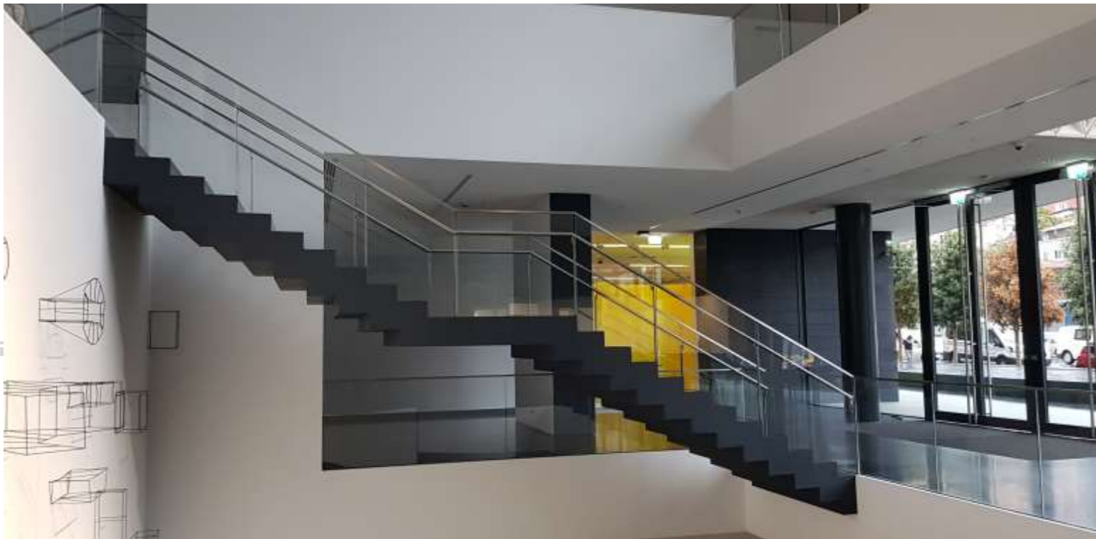
Vehbi Koç Vakfı Arter Müzesi Dolapdere İstanbul. Özel tasarım çelik konstrüksiyon merdiven ve cam ve paslanmaz çelik aksesuarlı merdiven korkulukları.
