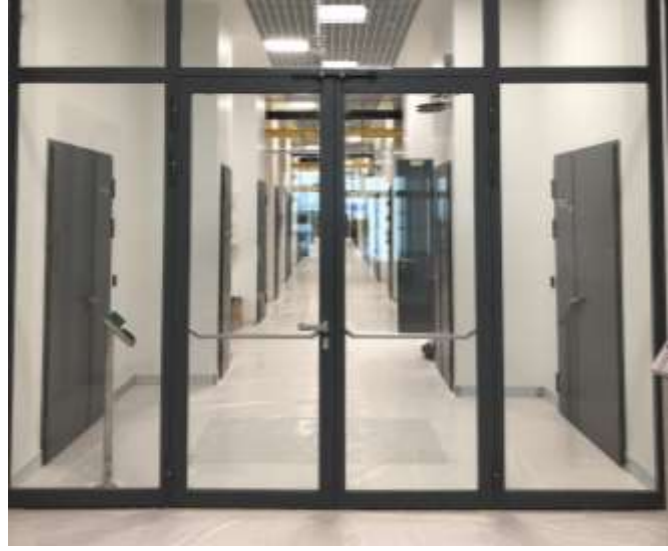
EI90 Camlı yangın bölmeleri ve camlı yangın kapıları Turkcel AVDC Merkezi, Gebze
